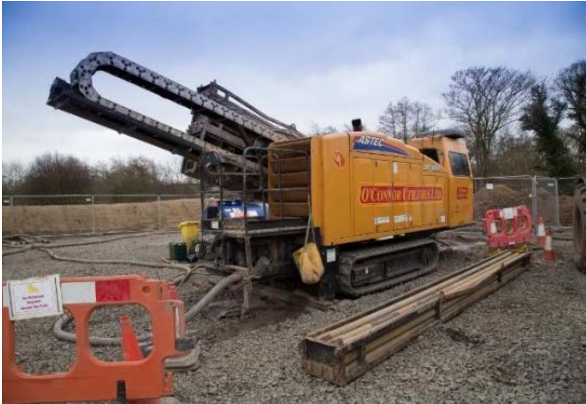
Plate 1 Example HDD rig (Source: Vattenfall Wind Power Ltd)
